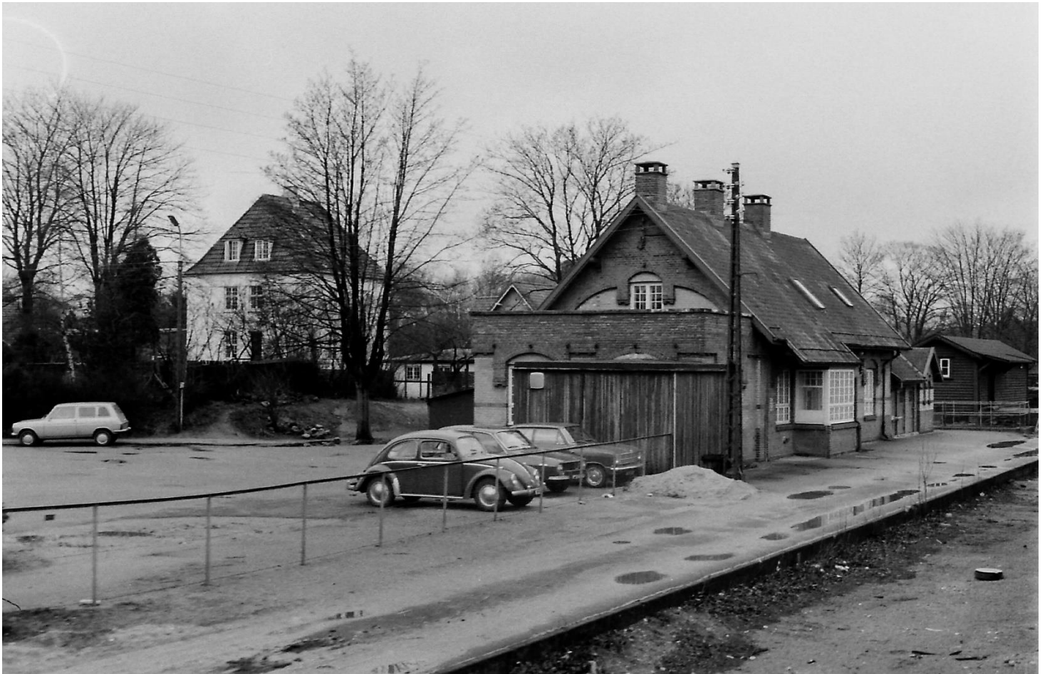
Den gamle stationsbygning, set fra perronsiden 9-4-1972 (K5702)
