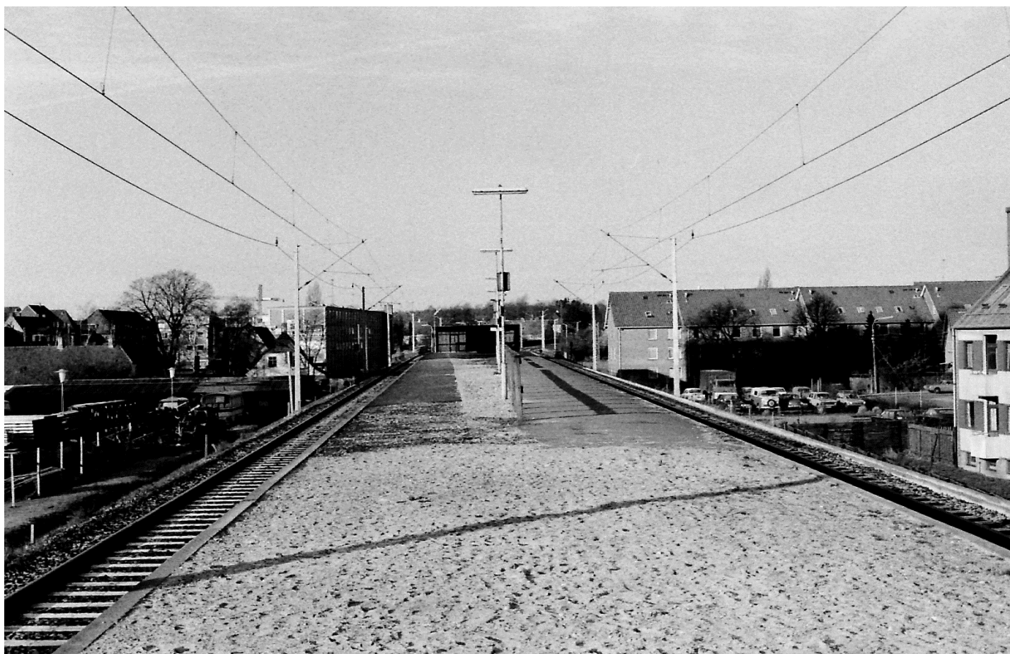
Nu med perron til begge sider og trappehus, set mod Farum 8-2-1975 (A6324)
